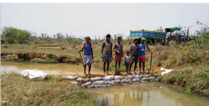
युवाचार्यों के निर्देशन में ग्रामीणों ने साधारण चेकडैम का निर्माण किया
